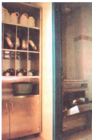
Εικ. 40 Πλυντήριο σκωραμίδων και ουροδοχείων.
