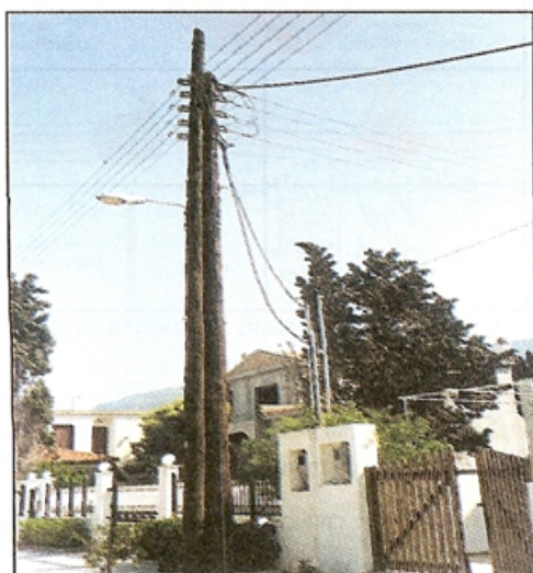
Εναέριες παροχές και μετρητές ηλεκτρικής ενέργειας
