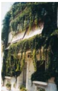
Εξωτερική ηλιοπροστασία με αναρριχώμενα φυτά και τέντες.
