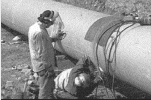
Εικόνα 7.1.8 Κατασκευή αγωγού μεταφοράς φυσικού αερίου στη Σιβηρία
