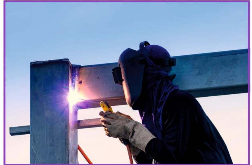
1 Ηλεκτροσυγκόλληση σε χαλυβδοδοκούς
